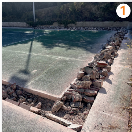
1 Terrassement et évacuation des terres
