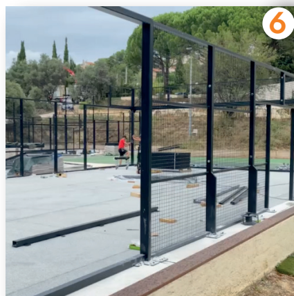
6 Mise en place des grilles
