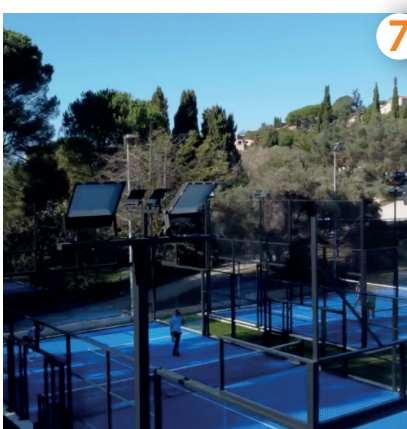
7 Installation des éclairages
