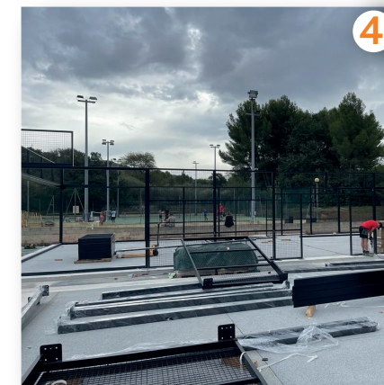
4 Installation de l'armature métallique
