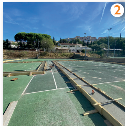
2 Fabrication de la dalle en béton poreux
