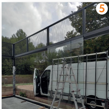
5 Réception et mise en place des vitres en verre
